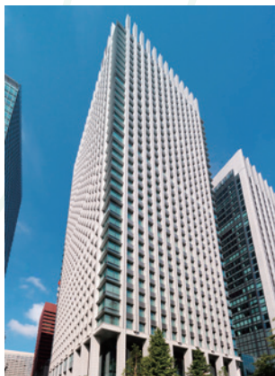
■大手町フィナンシャルシティサウスタワー
