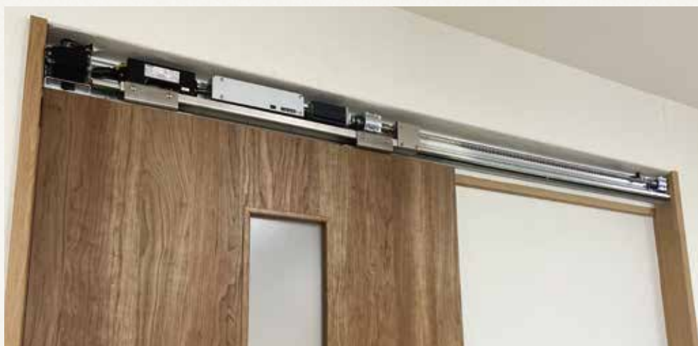
ストップセンサー センサーで挟まれを防止します。
