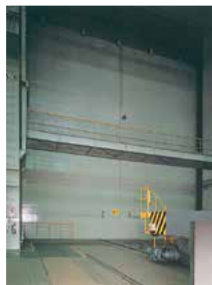
放射線防止両引き分けドアコンクリート充填 W18,000xH18,000 (ドア厚1,800)
