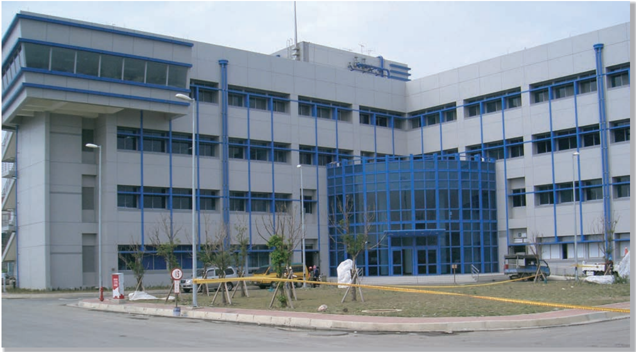
台灣高速鐵道中部(烏日)基地 行政綜合大樓 【台灣 台中縣】
